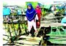
Jalan perantara yang rusak membuat pejalan kaki kesulitan melintasi jalan tersebut.
