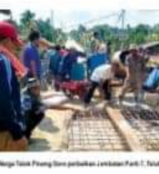
Warga Desa Pong (sore) perbaikan jembatan Part 1, Teluk Piang yang rusak.
