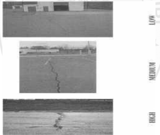
Gambar 2. 20 Retak Memanjang/Melintang (Longitudinal/Transverse Cracking) (Sumber: M.Y. Shahin 1990)
