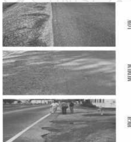
Gambar 2. 14 Retak Pinggir (Edge Cracking) (Sumber: M.Y. Shahin 1990)
