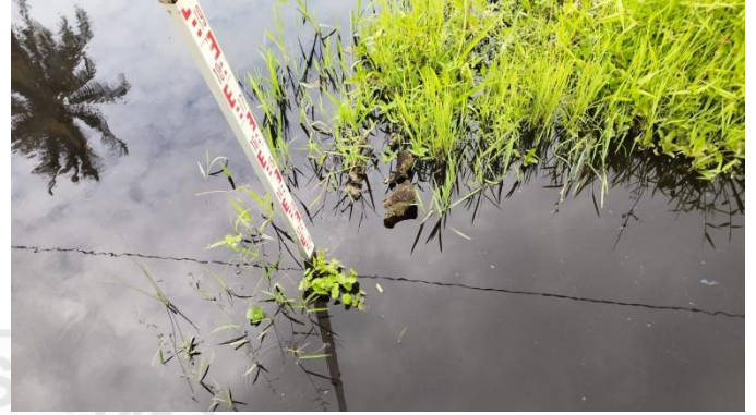
Mengukur kedalaman saluran eksisting anak sungai di parit 7 Jl Suhada II menggunakan rambu ukur
