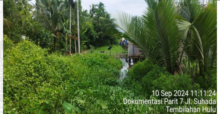
Kondisi Saluran anak sungai di Parit 7 Jl Suhada II
