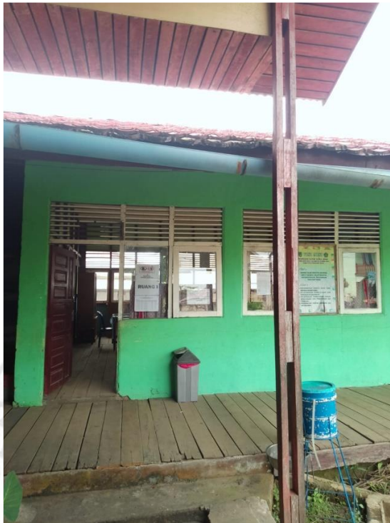
(Bangunan depan kelas)
