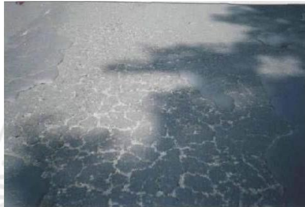
Gambar 2.20 Pelepasan Butir ( Weathering/Ravelling ) Sumber: Fitri (2022)
