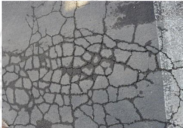
Gambar 2.2 Retak Kulit Buaya Sumber: Fitri (2022)
