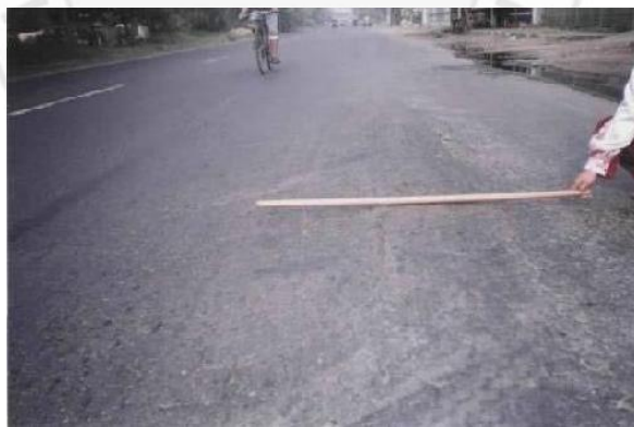
Gambar 2.19 Mengembang Jembul ( Swell ) Sumber: Fitri (2022)
