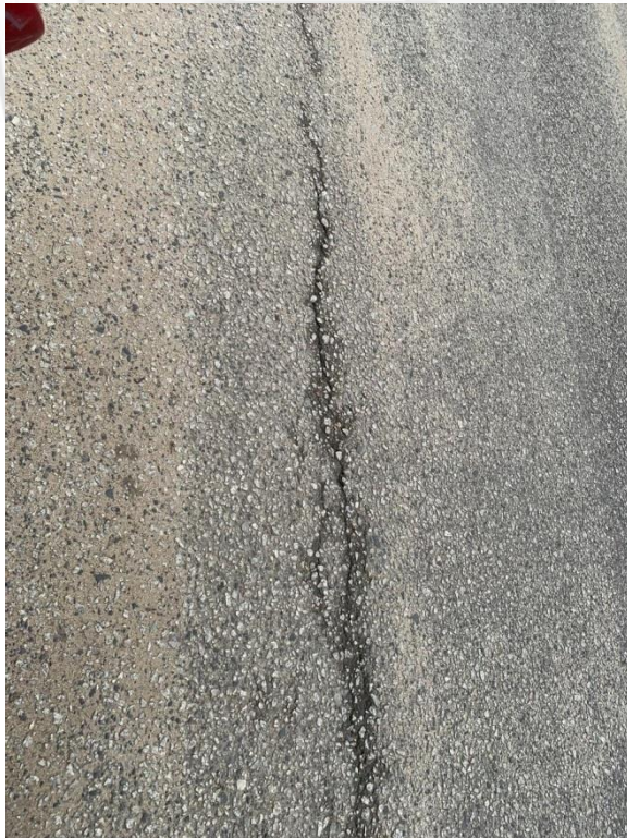
Gambar.2 Jenis Kerusakan Retak Memanjang/Melintang (Sumber : Hasil Analisis, 2026)
