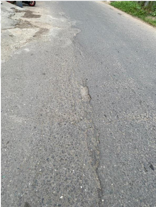
Gambar.6 Jenis Kerusakan Retak Pinggir (Sumber : Hasil Analisis, 2026)
