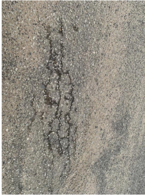
Gambar 3 Jenis Kerusakan Retak Buaya (Sumber : Hasil Analisis, 2026)
