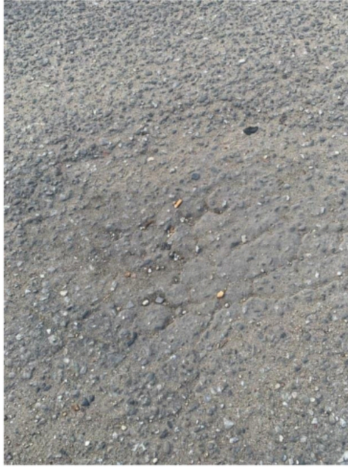
Gambar.7 Jenis Kerusakan Amblas ( Sumber : Hasil Analisis, 2026 )
