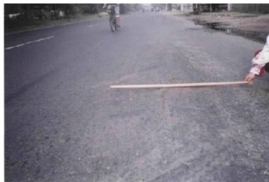
Gambar 2.19 Mengembang Jembul ( Swell ) Sumber: Fitri (2022)
