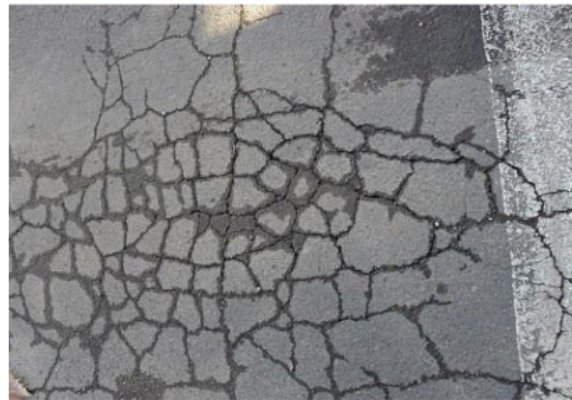
Gambar 2.2 Retak Kulit Buaya
