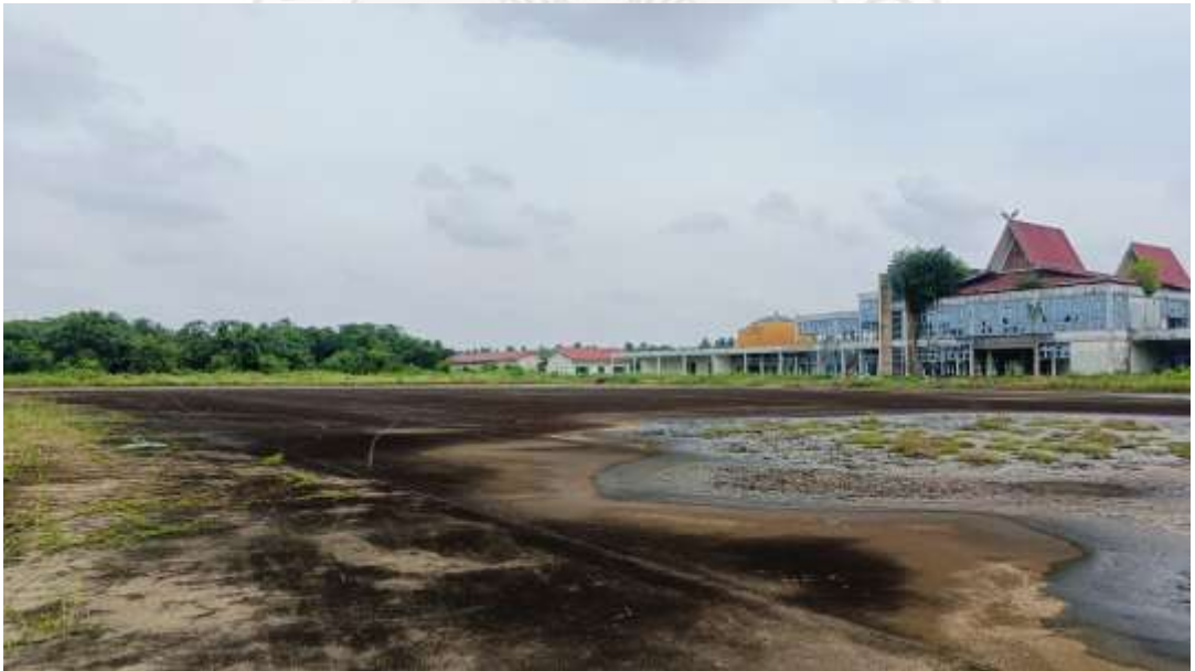
Survei Kondisi Lapangan
