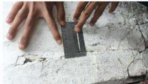
Gambar 4. 22 Titik kerusakan pada lantai
