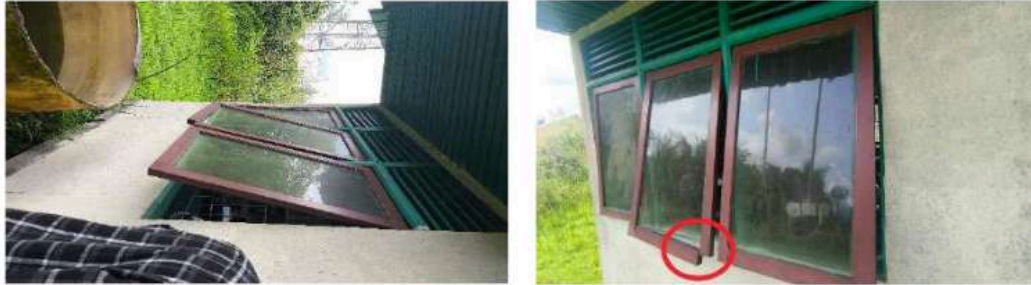
Gambar 4. 27 Kondisi jendela di lapangan
