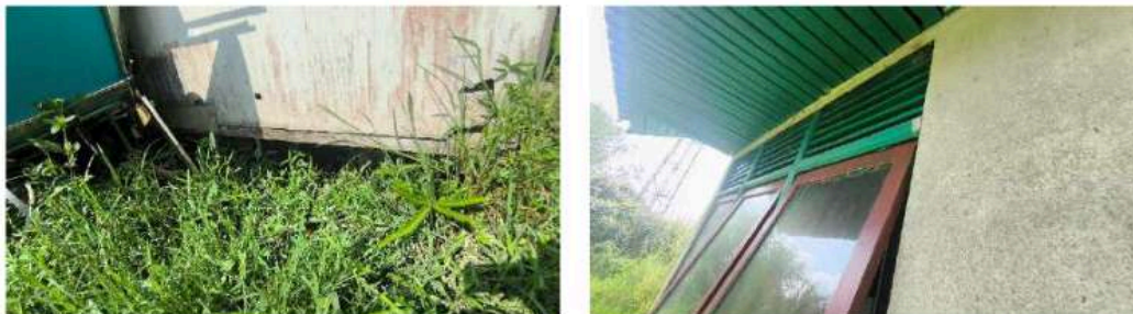
Gambar 4. 37 Kondisi finishing/cat di lapangan
