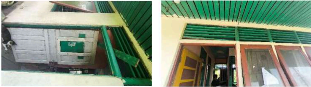
Gambar 4. 29 Kondisi ventilasi di lapangan
