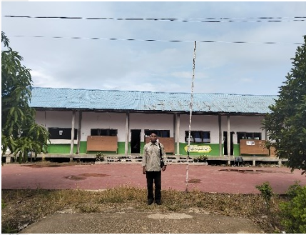
gambar 14 gedung smp mahad tahfidz hayatu
