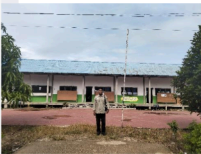
gambar 14 gedung smp mahad tahfidz hayatu
