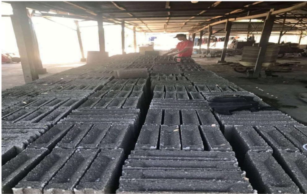
Gambar 1. Proses curing (Pengeringan) Produk Beton
