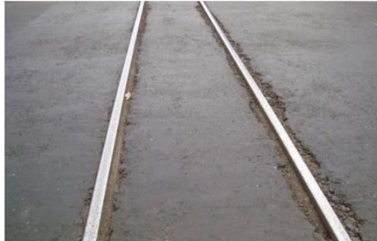
Gambar 2. 14 Persilangan Jalan Rel
