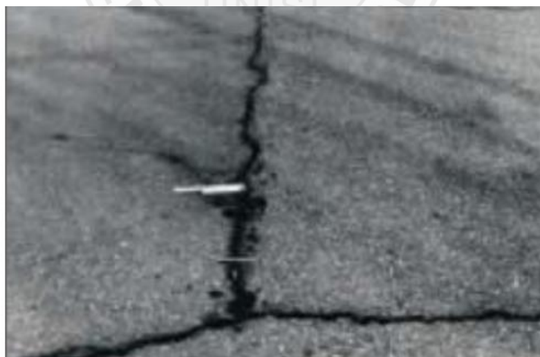
Gambar 2. 4 Retak Sambungan
