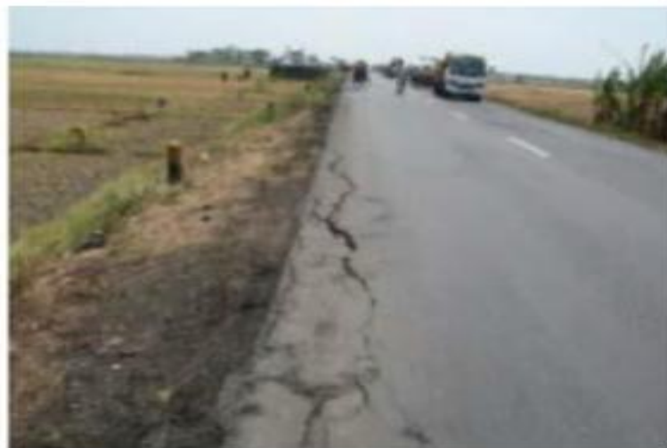
Gambar 2. 3 Retak Tepi
