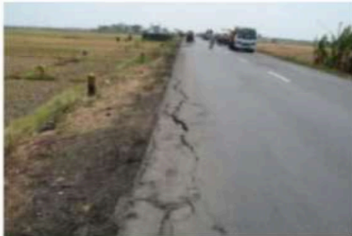
Gambar 2. 3 Retak Tepi
