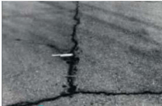
Gambar 2. 4 Retak Sambungan
