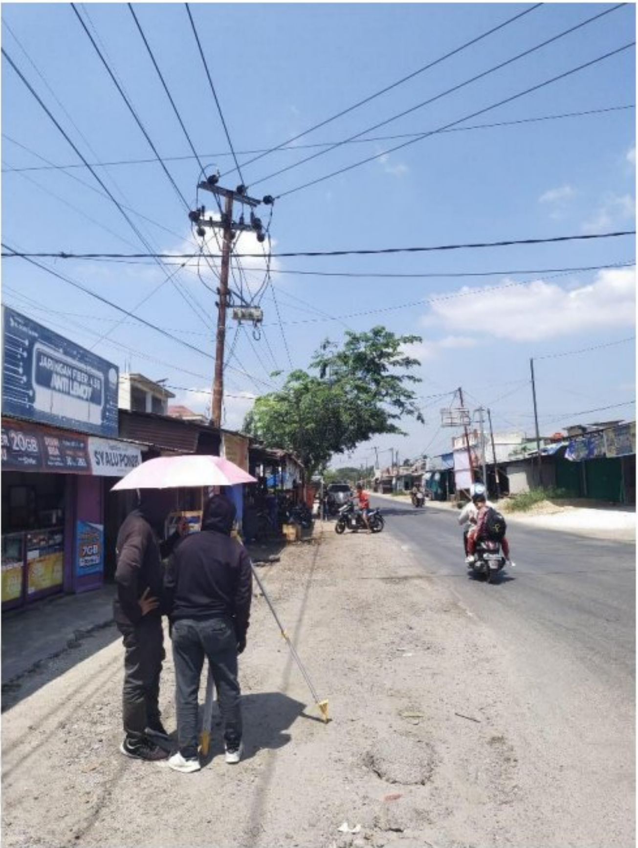
Foto pengambilan elevasi dengan alat waterpass
